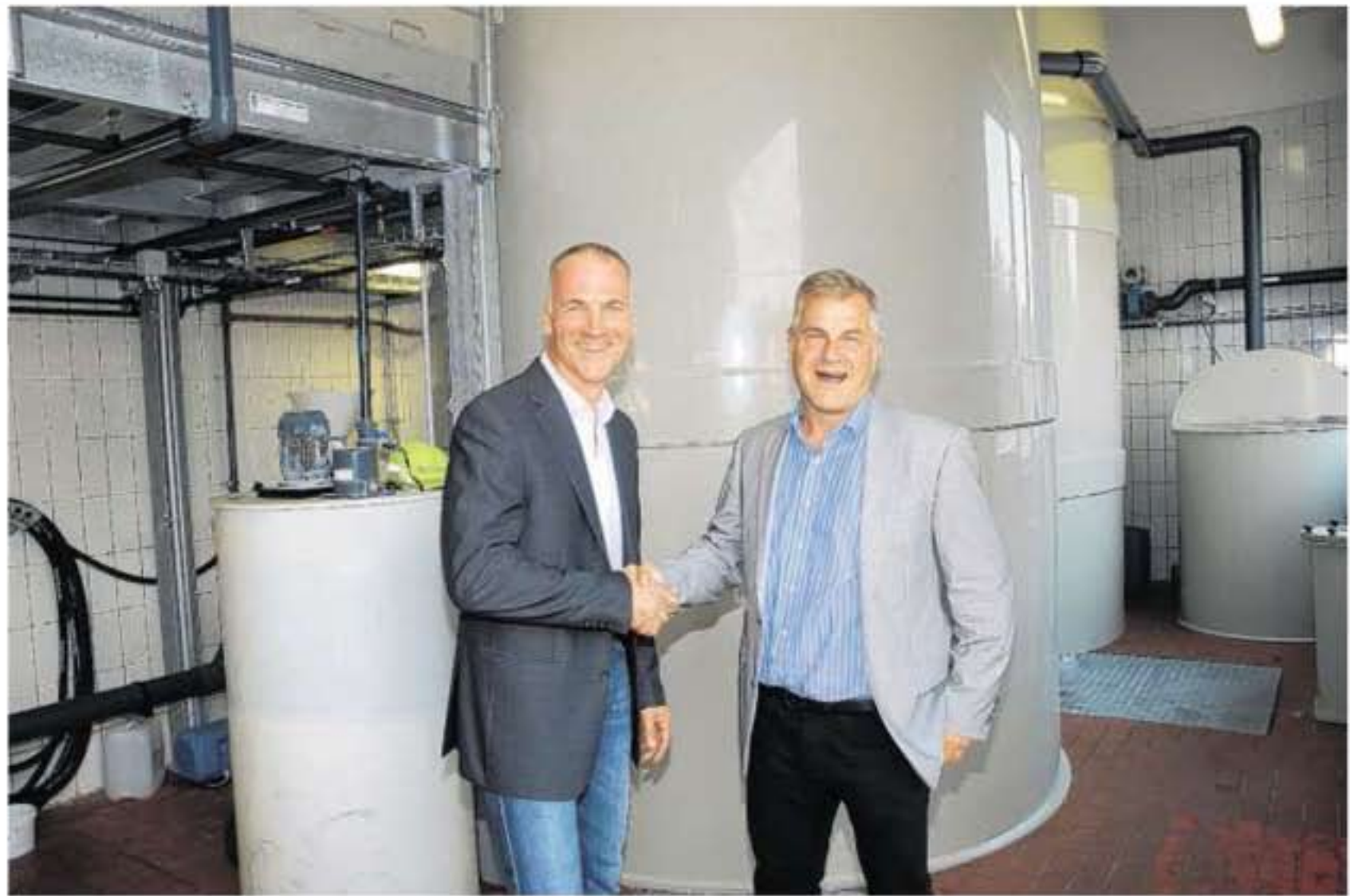
Gute Partner: Dr. Michael Nitsche (rechts), Werksleiter von Bostik in Borgholzhausen, und Dr. Jörg Wellenbüscher, Geschäftsführer bei der Zimmermann-Gruppe in Gütersloh, freuen sich über die Inbetriebnahme der neuen Abwasserreinigungsanlage im heimischen Bostik-Werk. Teile der Anlage sind im Hintergrund zu sehen.
