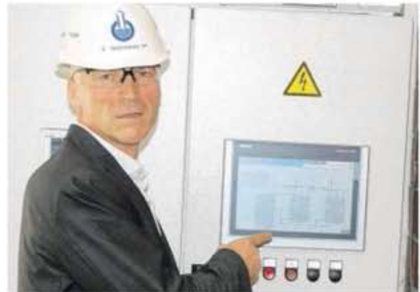
Steuerung: Über eine berührungsempfindliche Oberfläche kann die neue Abwasserreinigungsanlage der Firma Zimmermann bei Bostik gesteuert werden. Dr. Jörg Wellenbüscher demonstriert die Funktion. Er hat vom eigenen Büro aus über das Internet einen kontrollierenden Zugriff auf die Steuerungen aller vom ihm betreuten Anlagen.
